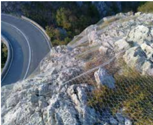
Rete paramassi posata in Croazia
