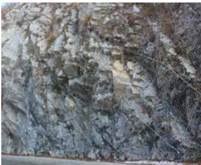
Rete paramassi posata a Sogno (BG)
