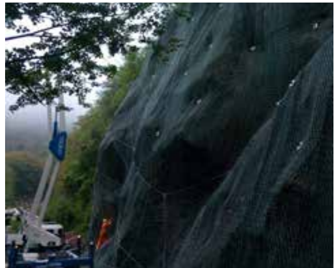
Fasi di posa geocomposito ArrFort Pet
