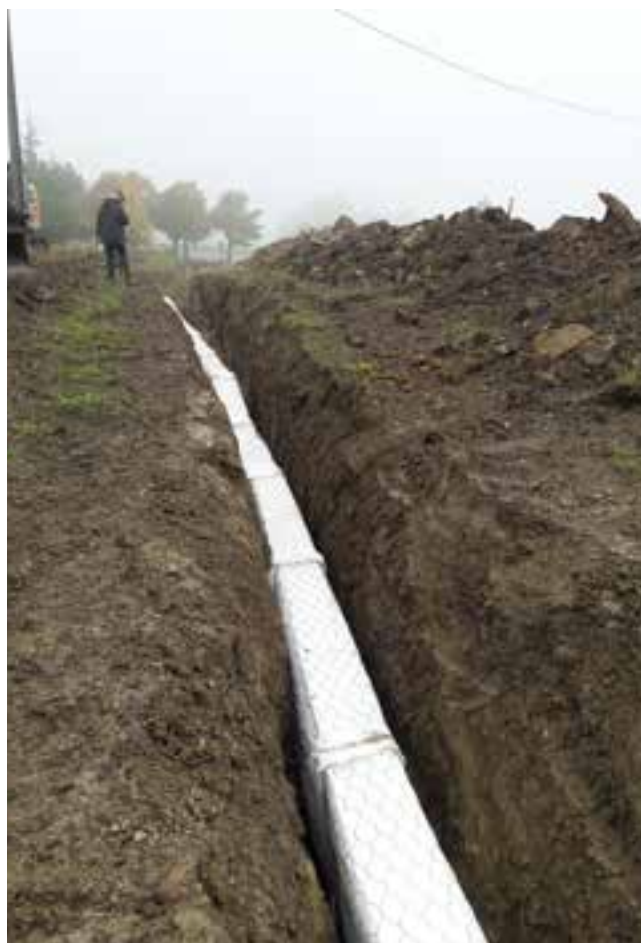
Drenaggio in terreno agricolo - Loc. Costa Rustigazzo (PC)
