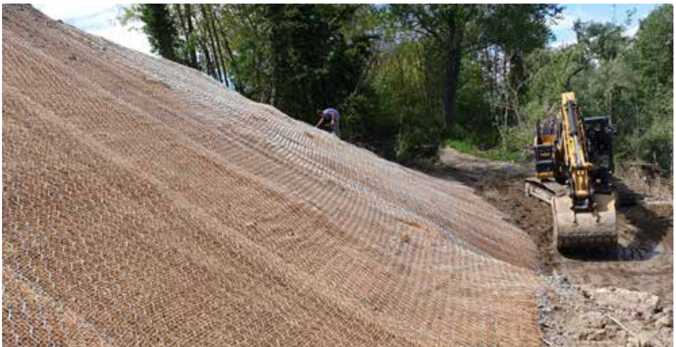
Rivestimento arginale ed antinutria a basso impatto - Mantova
