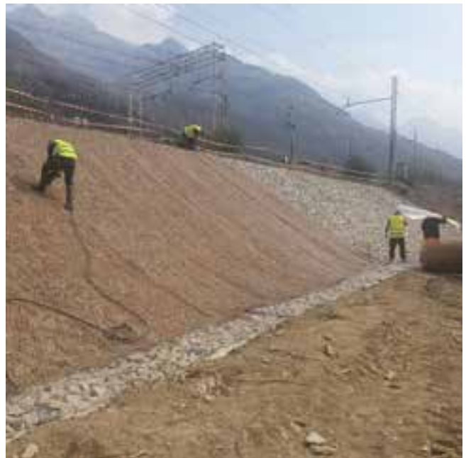
Rivestimento antierosivo misto con Arrldro e materassi di sottoscarpa ferroviaria - Domodossola (VB)
