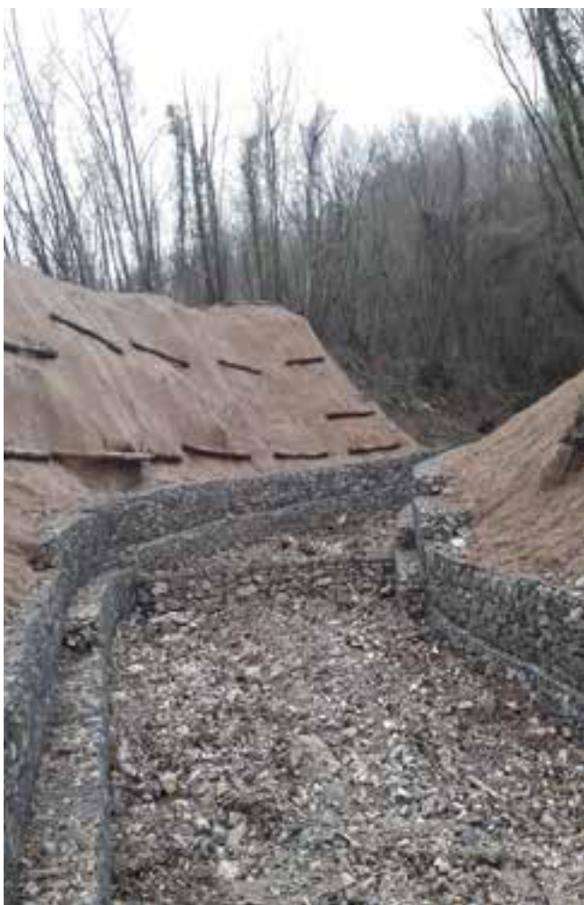
Sistemazione idraulica e stabilizzazione versanti a basso impatto gabbioni e geocomposito Arco - Genova
