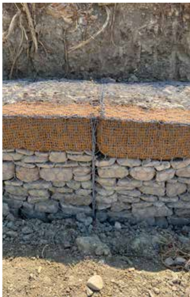
Gabbioni rinverdibili con tasche vegetative - Pavia
