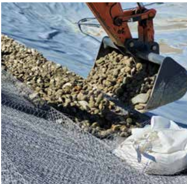
Posa materassi protezione spondale bacino innevamento - Bielmonte (BI)
