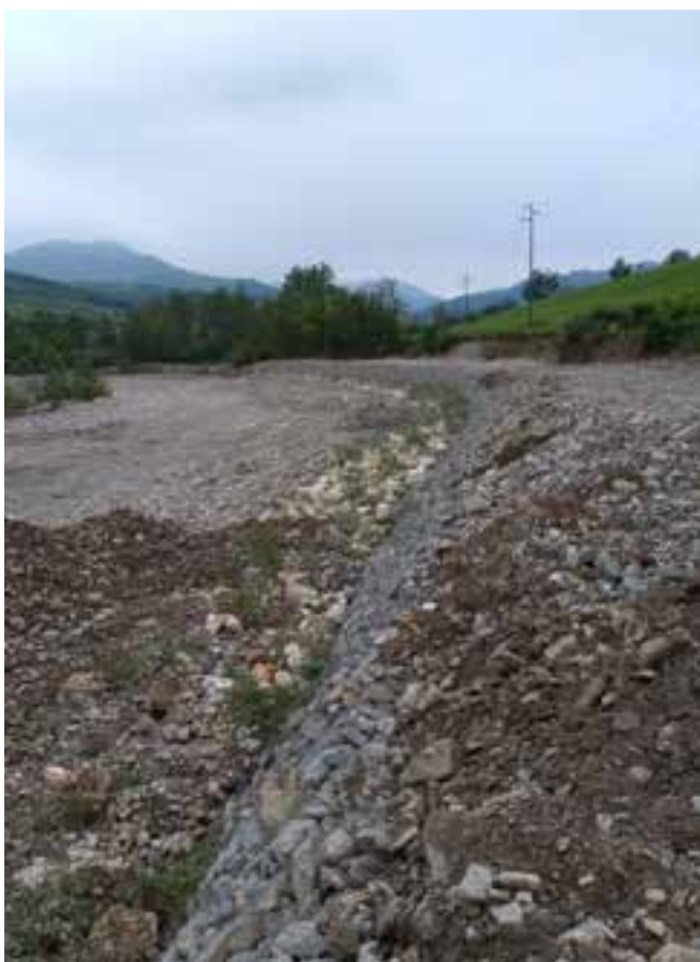
Difesa spondale in gabbioni cilindrici - Lugagnano (PC)
