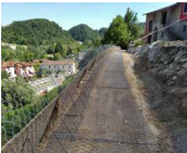
Allargamento stradale e consolidamento versante - Pontremoli (MS)
