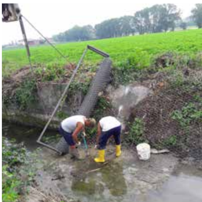
Posa reti antinutria in alveo - Castell'Arquato (PC)
