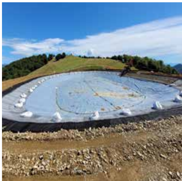
Materassi in protezione bacino di innevamento - Bielmonte (BI)
