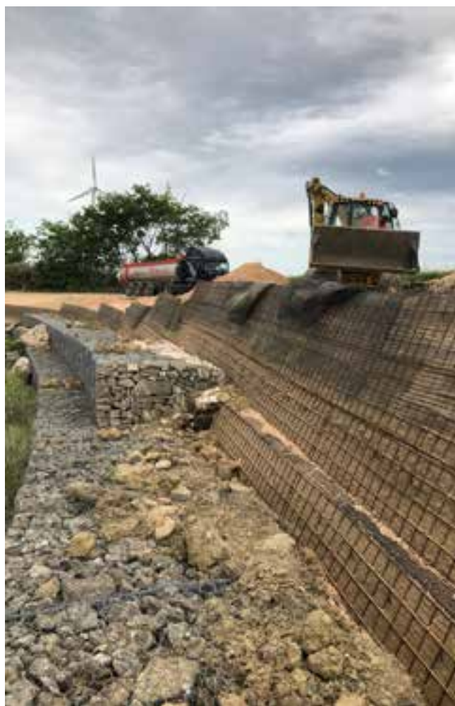
Opera mista con base in gabbioni e sommità in terre rinforzate - Acerenza (PZ)
