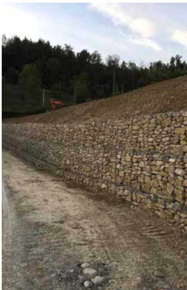
Opera di controripa stradale - Travo (PC)
