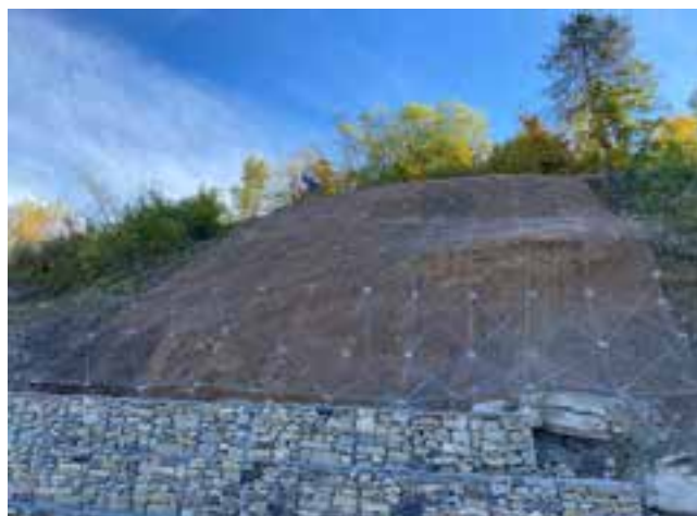
Sistema Arco, stabilizzazione sottoscarpa stradale in terreno sciolto, con gabbionata al piede - Ferriere (PC)
