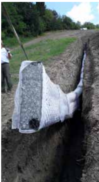
Trincea drenante a sezione obbligata in pista da sci - Veneto
