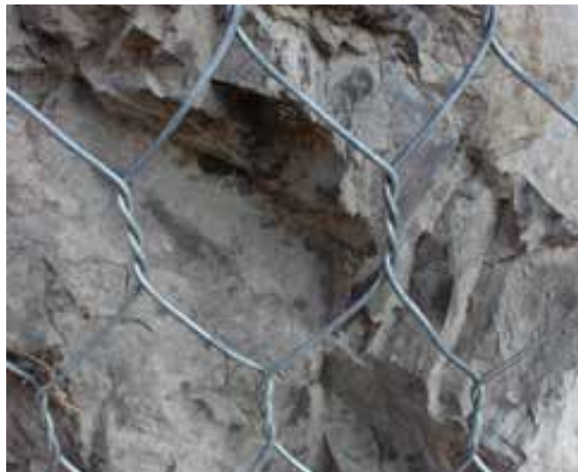
Rete paramassi posata a Sogno (BG)
