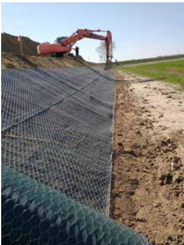
Posa arginale rete antigambero ed antierosiva - Rottofreno (PC)
