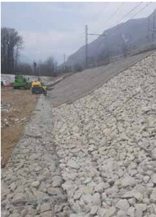
Rivestimento sottoscarpa ferroviario - Domodossola (VB)
