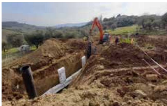
Posa in opera della tratta drenante - Tortoreto (TE)
