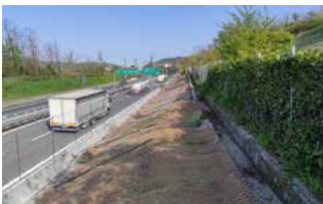
Arco, versante autostradale A7 in terreno Vignole Borbera (AL)
