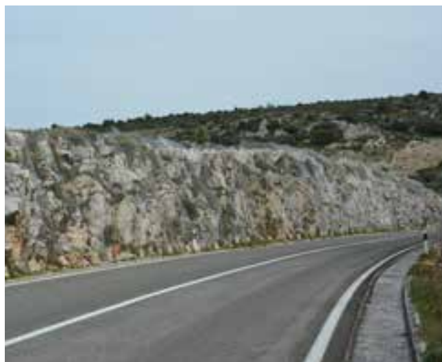
Rete paramassi posata in Croazia
