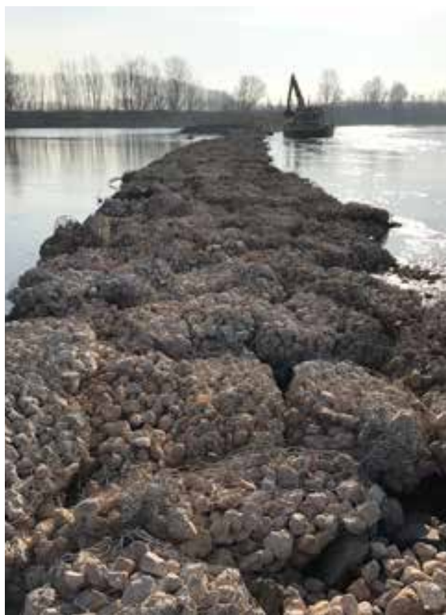
Pennello in burghe - Fiume PO Torre d'Oglio
