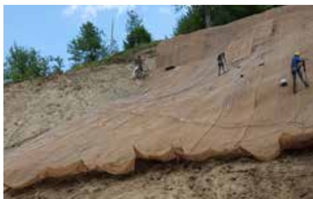
Arco fase di posa in opera - Valle Castellana (TE)
