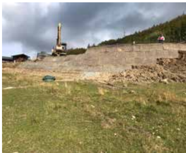
Rilevato di sottoscampa per nuova pista da sci - Sestola (MO)
