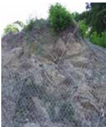
ArrMet per il rafforzamento di versante in roccia fratturata - Genova
