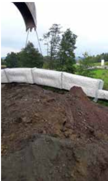
Facilità di sollevamento e movimentazione anche su corpi di frana - Val Pusteria (BZ)
