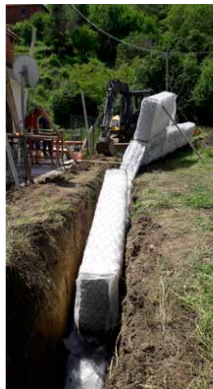
Drenar protezione fondazione in spazi ristretti con camino drenante e guaina - Tresana (MS)
