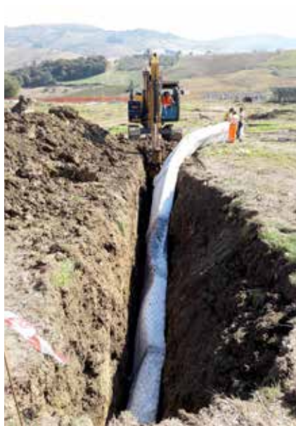
Drenar posa in continuità in terreni spingenti - campo fotovoltaico Volturara Appula (FG)
