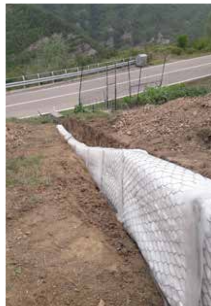
Drenaggio in controripa a protezione di piano viabile - Ottone (PC)
