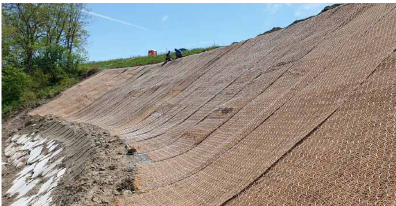
Rivestimento arginale ed antintrusiva a basso impatto - San Secondo (PR)
