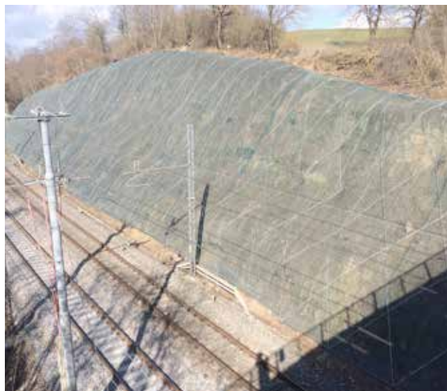
ArrPet, stabilizzazione versante ferroviario con terreno molto fine - zona Orte (VT)
