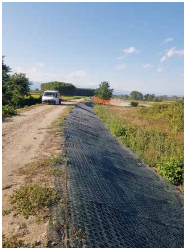
Rete antierosiva ed antigambero per protezione arginale - Balocco (VC)
