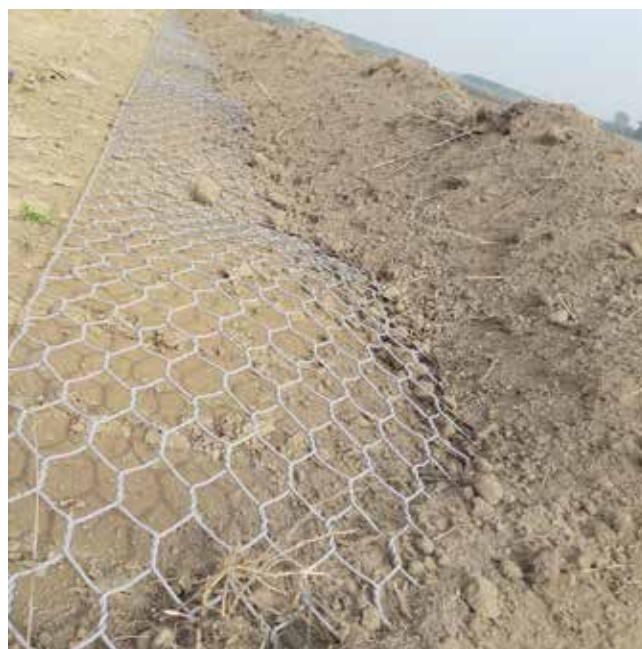
Ricoprimento rete antinutria con terrame di scotico , dettaglio
