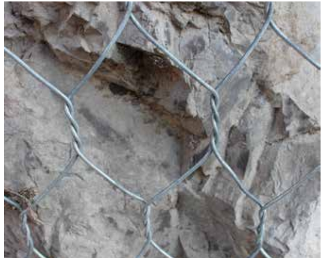
Rete paramassi posata a Sogno (BG)
