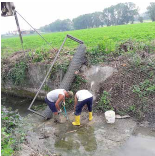
Posa reti antinutria in alveo - Castell'Arquato (PC)
