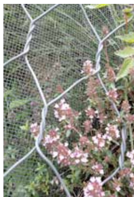
ArrPet dettaglio trattamento matrice fine e rinaturazione - Boccassuolo (MO)
