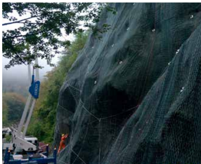
Fasi di posa geocomposito ArrFort Pet
