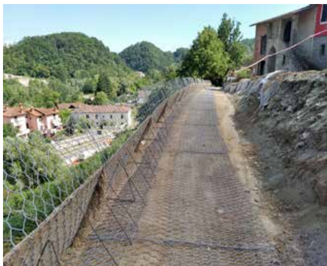
Allargamento stradale e consolidamento versante - Ponremoli (MS)
