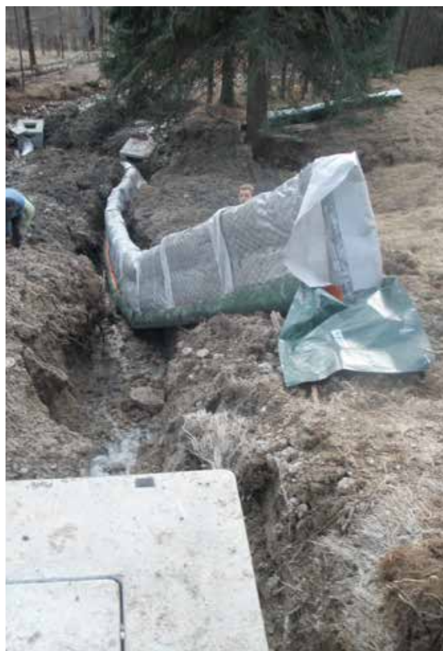
Posa in area forestale difficilmente accessibile - Selva di Cadore (bl)
