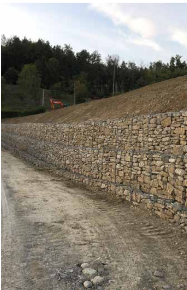
Opera di controripa stradale - Travo (PC)
