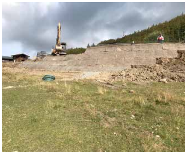
Rilevato di sottoscrapa per nuova pista da sci - Sestola (MO)
