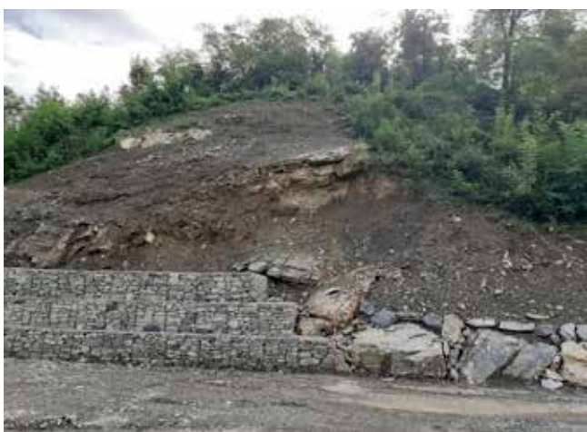
Situazione versante sottoscarpa Ferriere preintervento
