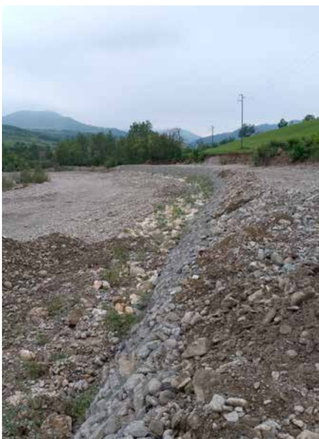
Difesa spondale in gabbioni cilindrici - Lugagnano (PC)
