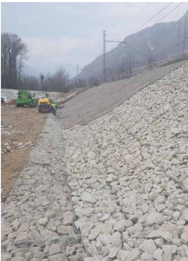
Rivestimento sottoscarga ferroviario - Domodossola (VB)
