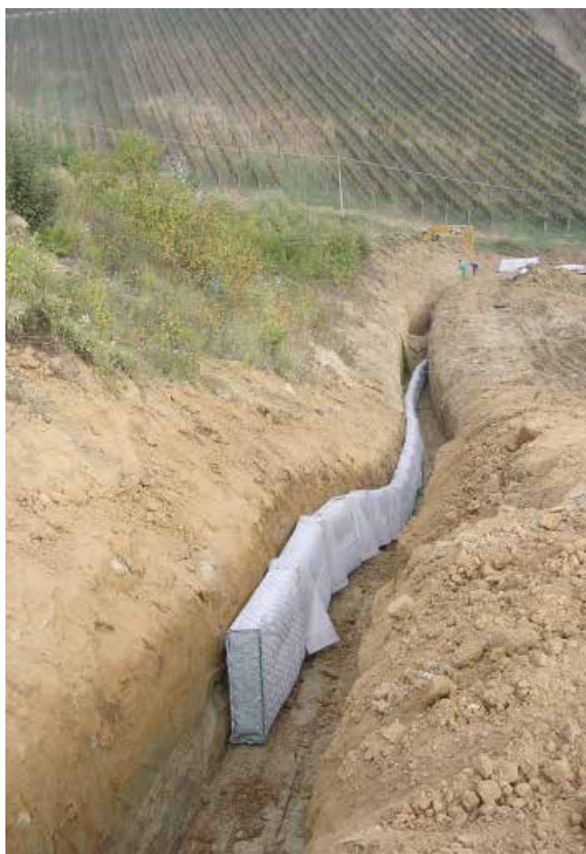
Drenaggio a sezione in vigneto - Loc. Boschi di Acqui Terme (AT)
