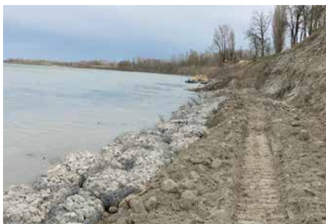
Difesa spondale in burghe - Fiume PO Torre d'Oglio
