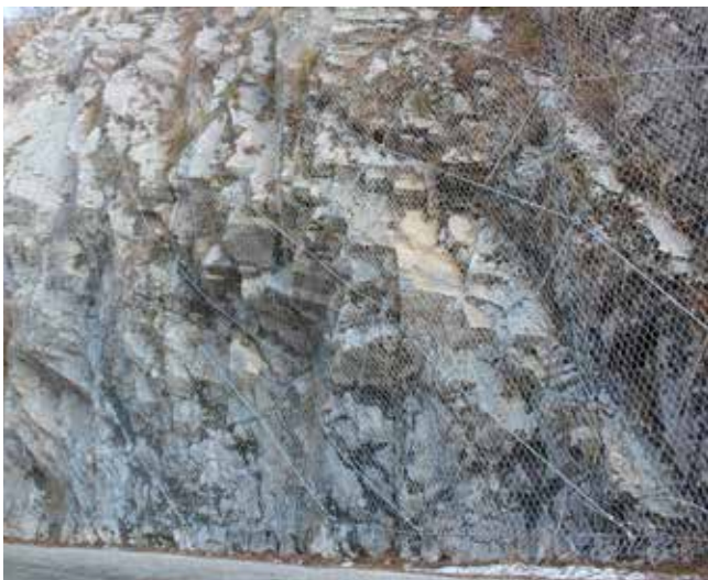
Rete paramassi posata a Sogno (BG)
