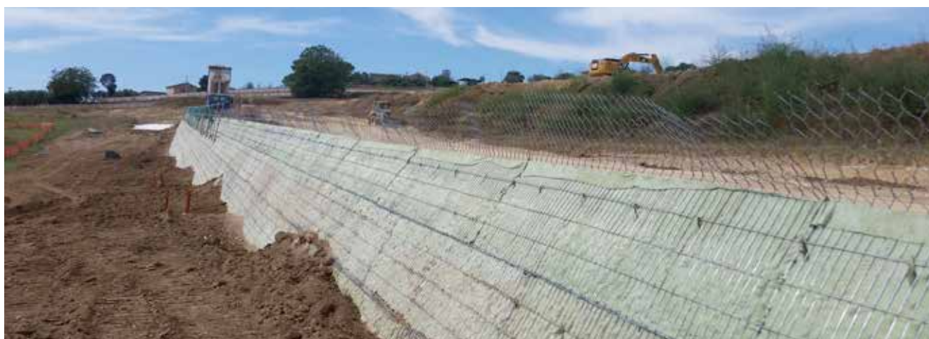
Nuovo rilevato stradale per accesso ospedale di Fermo
