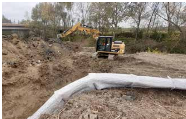
Drenar in ripristino frana d'alveo, in dettaglio l'elevata flessibilità dei moduli - Cesena
